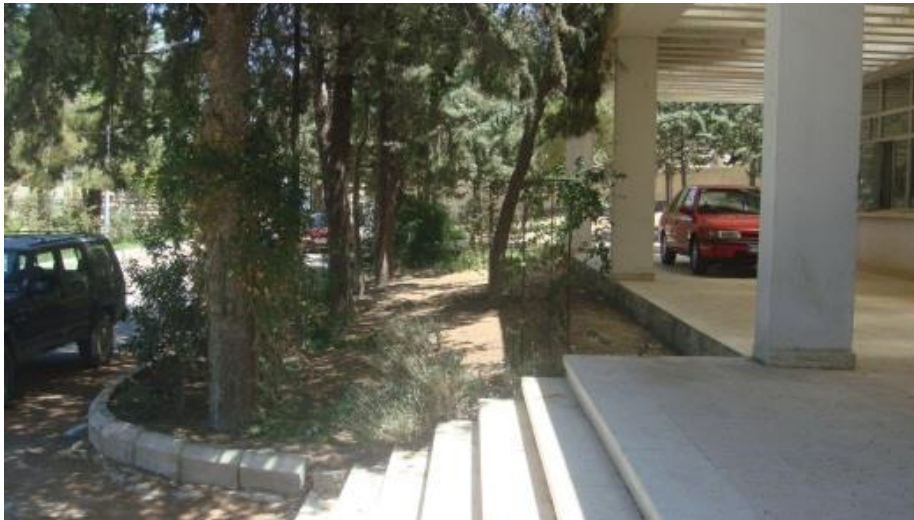
صورة للمدخل الرئيسي قبل بناء المنحدر.
