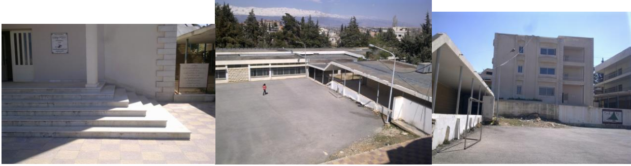
صور لمبنى قسم التجارة والمحاسبة والملعب قبل التدخل
